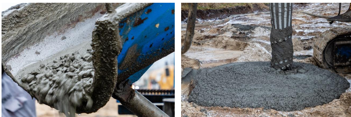
Rys. 25 – Przebieg pompowania mieszanki J1 przez układ palownicy.
