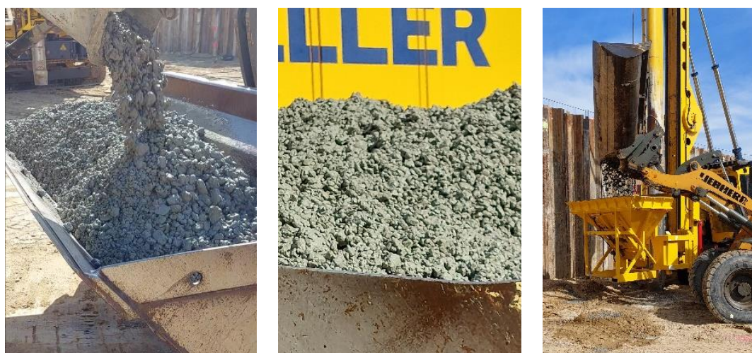
Rys. 51 – Załadunek mieszanki do ładowarki i napełnianie kubła transportowego podczas realizacji pala.
